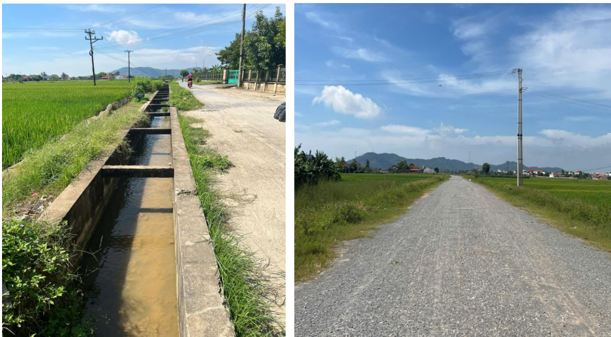
Hình 1. 3. Hiện trạng hạ tầng khu vực dự án
